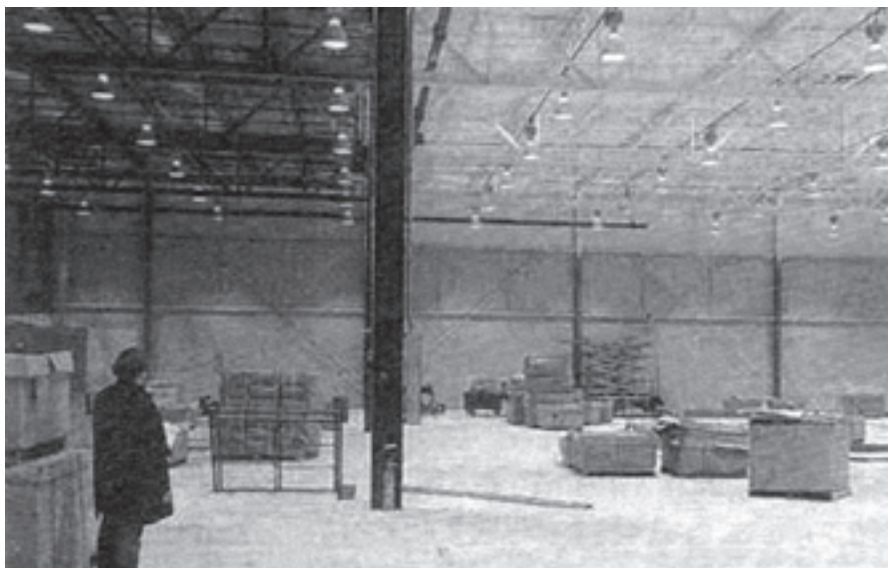
شکل ۲۴-۳- سیستم روشنایی عمومی
