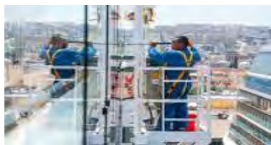
شکل ۱۴-۱ کار کردن در ارتفاع
