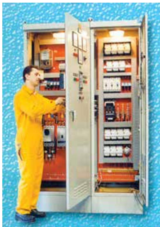
شکل ۲-۹- نمونه‌ای از تابلو توزیع برق
